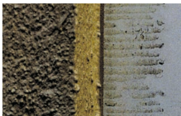
Restos de Adhesivo - Cinta retirada a temperaturas por debajo del punto de congelación
